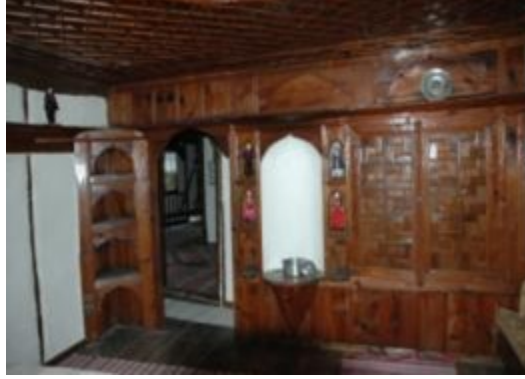
Resim 5: Hacı Şakirler Konağı duvar kaplaması
