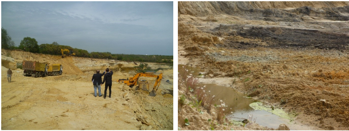
Şekil 1 Maden sahasındaki rehabilitasyon çalışmasından görünüm[11]
