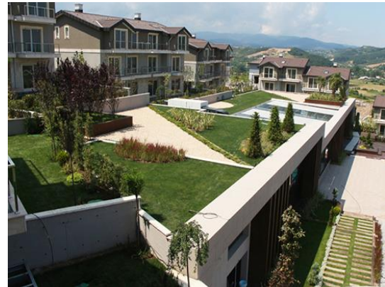
Şekil 2. Yeşil Çatı Türkiye uygulaması (Yalova) [3]
