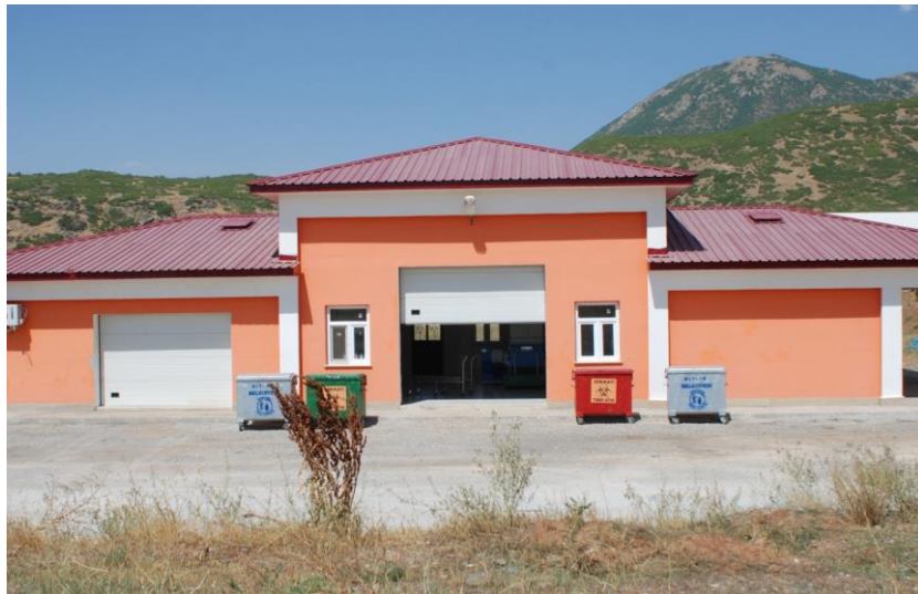
Şekil 1. Bitlis Tıbbi Atık Sterilizasyon Ünitesi [5]
